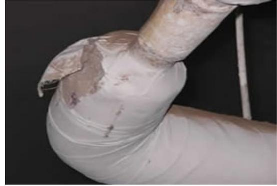
Torn asbestos pipe lagging
